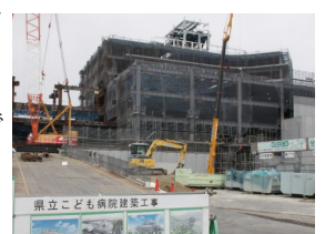
批判をよそに建設が進むこども病院
